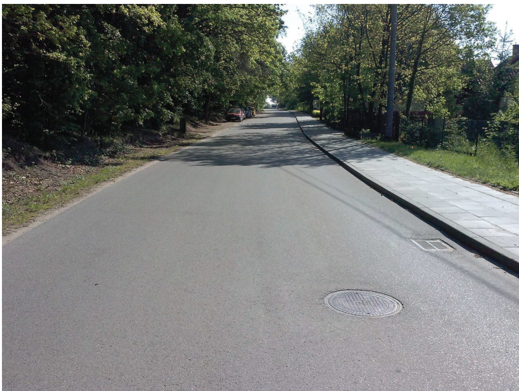
Fot.14. Km 1+470. Przekrój uliczny. Odwodnienie do kanalizacji deszczowej.
